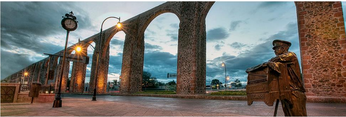
ACUEDUCTO EN QUERÉTARO, MÉXICO
